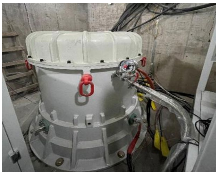
图 3 磁悬浮飞轮储能单元应用场景
